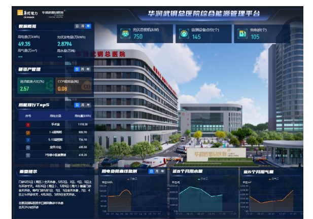
华润武钢总医院综合能源管理平台
