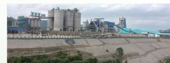
金沙水泥进厂大道侧边坡
