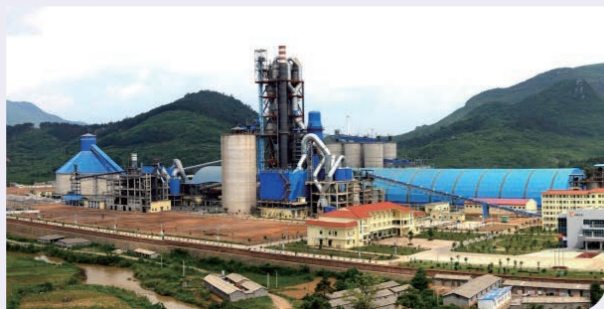
华润水泥生产线全景
