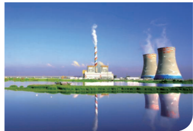
图为投资1.2亿元进行“超低排放”改造的华润电力广州热电厂，是广东省第一家完成“超低排放”改造的燃煤电厂，每年比国家标准多减排二氧化硫2,432.76吨、氮氧化物966吨、粉尘220吨。
